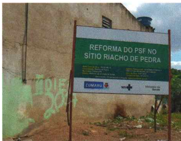
Foto 4 - Visão externa do PSF Riacho de Pedra Placa de obra
