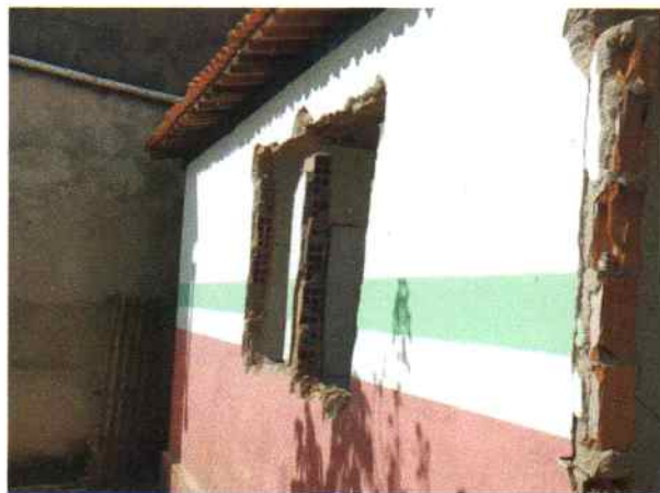
Foto 9 - Visão externa do PSF Riacho de Pedra Retirada das esquadrias
