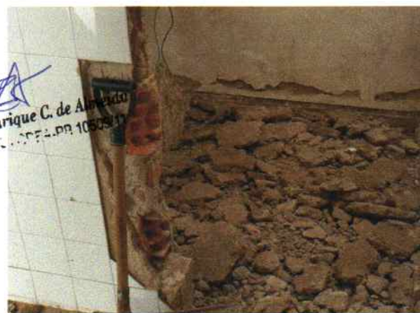
Foto 6 - Visão interna do PSF Riacho de Pedra Demolições do revestimento de piso
