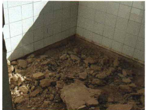
Foto 10 - Visão interna do PSF Riacho de Pedra Demolição do revestimento de piso
