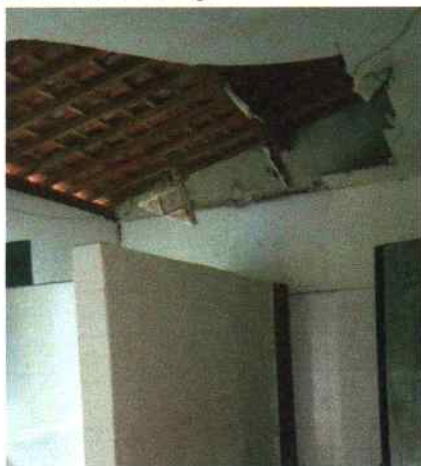
Foto 3 - Visão interna do PSF Riacho de Pedra antes do início dos serviços
