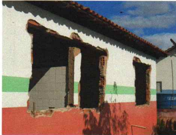
Foto 7 - Visão externa do PSF Riacho de Pedra retirada das esquadrias
