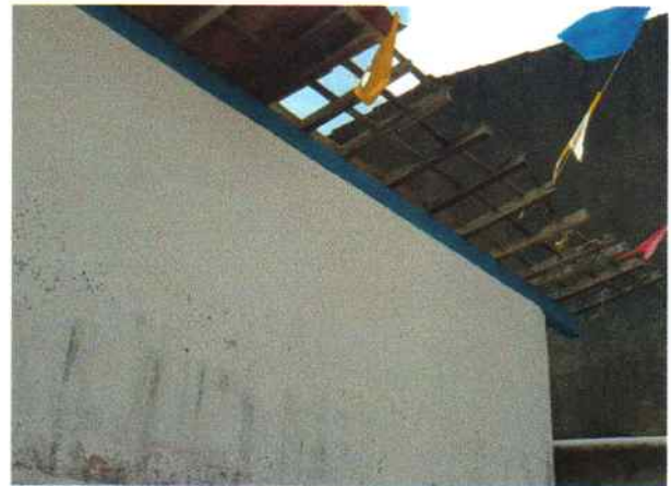
Foto 8 - Visão externa do PSF Riacho de Pedra Detalhe do retelhamento
