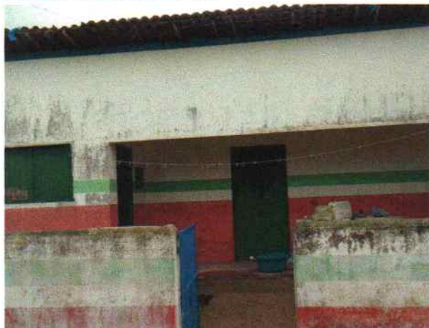
Foto 1 - Visão externa do PSF Riacho de Pedra antes do início dos serviços
